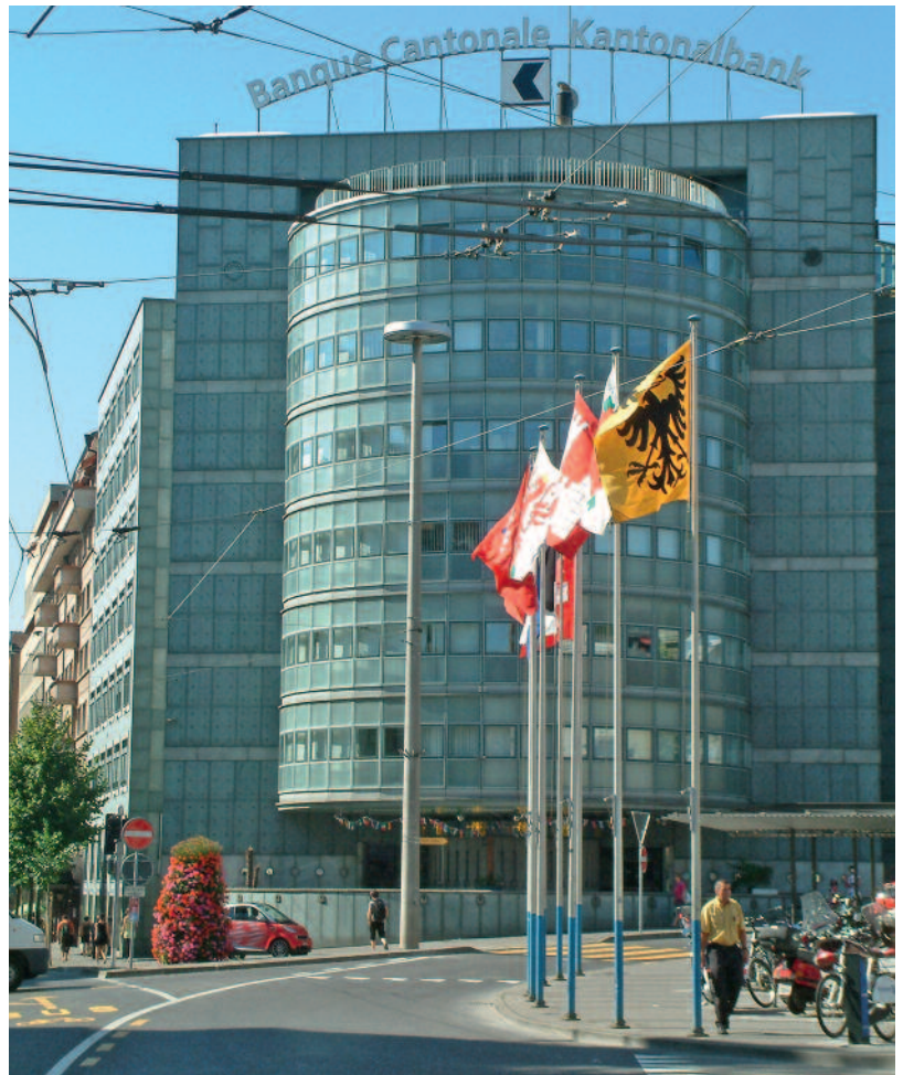
Die Kantonalbank Freiburg.
