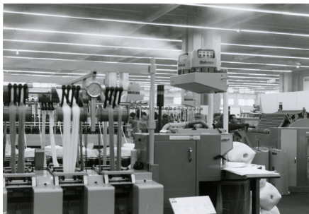
Rotationszerstäuber 13T im Maschinenbauunternehmen SACM in Mulhouse
