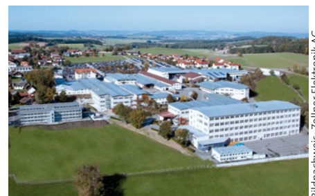
Hauptwerk der Zollner Elektronik AG
